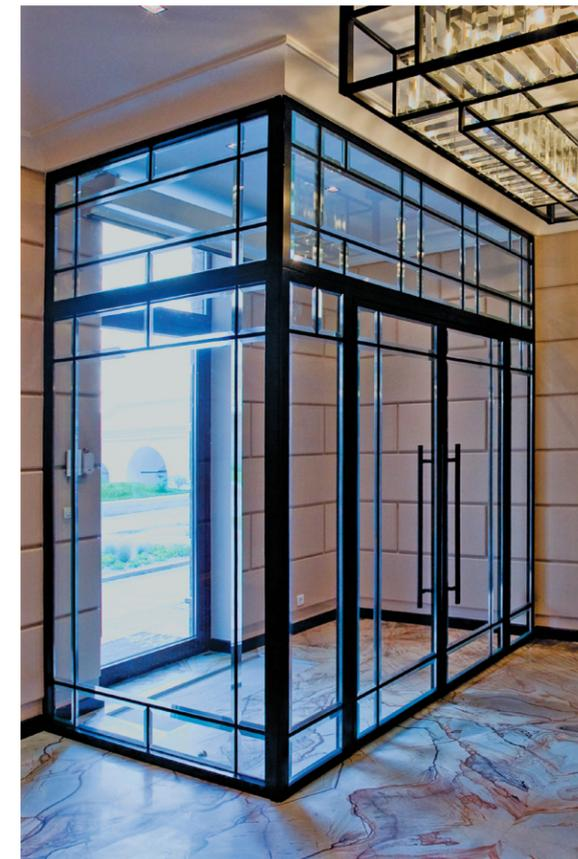
Применение сварочных работ при создании конструкций, выполненных из профиля VOESTALPINE, обеспечивает дополнительную прочность в местах соединения профилей, что позволяет создавать высокие перегородки и двери. Порошковая окраска защищает поверхность конструкции и сохраняет ее эстетическую привлекательность в течение многих лет.
