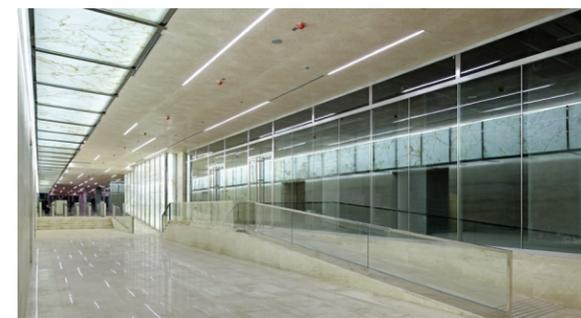
Конструкции из профильных систем FORSTER обладают высокими технологическими характеристиками, устойчивы к коррозии и легко перерабатываются. Прочные соединения сварных углов позволяют создавать перегородки нестандартной высоты.
