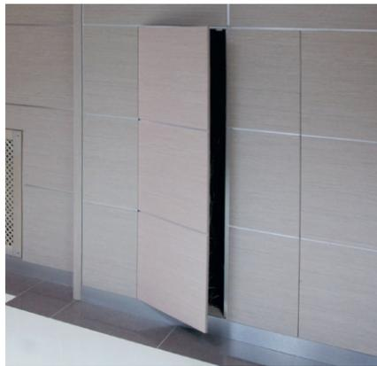
Позволяет сделать одну или несколько панелей со скрытым открыванием (доступ к коммуникациям), при этом сохраняя при этом внешний вид разбивки панелей на стене.
