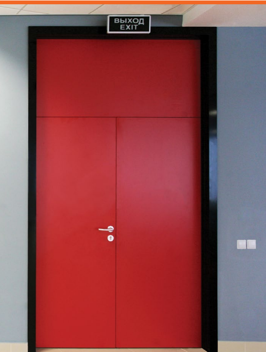
Объект Офис компании РЖД Тип дверей FIREPROOF EIW-60
