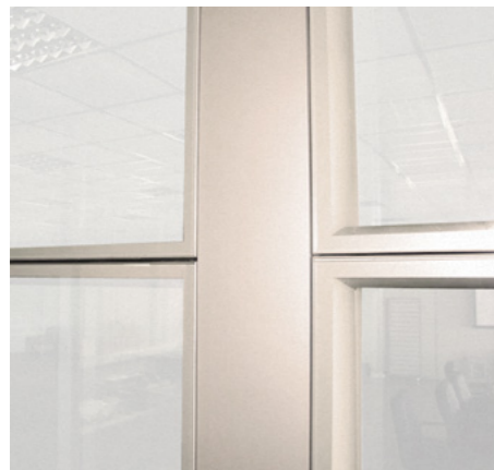
D Соединение 3х стен 3 wall connection
